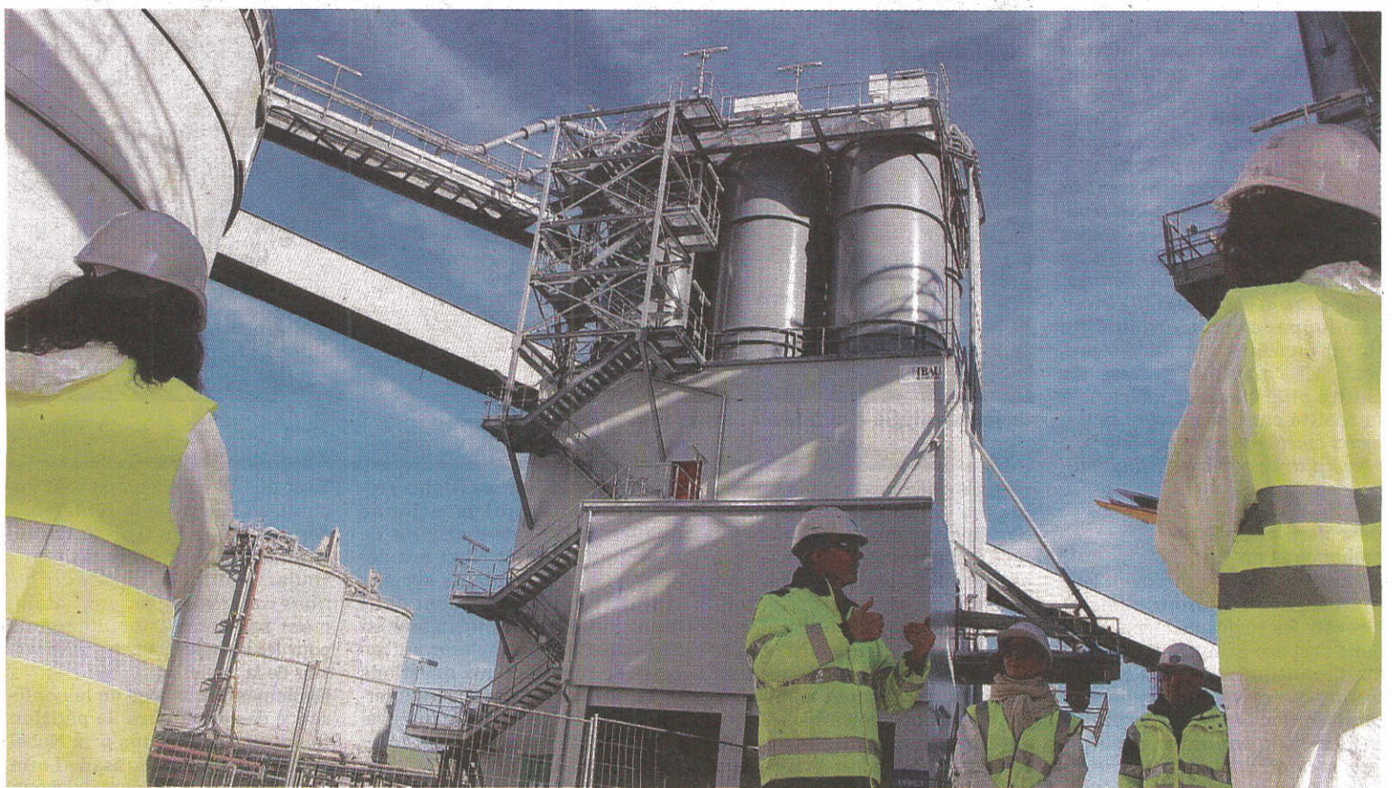
Cette installation, nouvelle sur le site, permettra de récupérer les cendres issues de la combustion, revalorisées dans les cimenteries. S.G.
